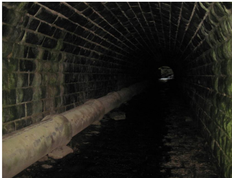
Ouvrage sous la voie ferrée
